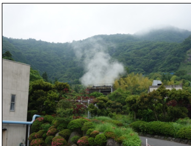
Sホテル地熱発電所
